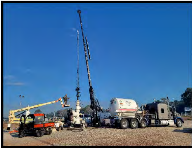
Nitrogen Injection MIT Well 101 A
