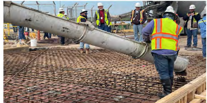
Concrete Pour Begins
