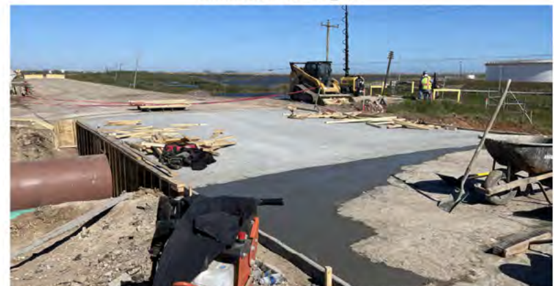
External Levee Crossing - Pour Completed
